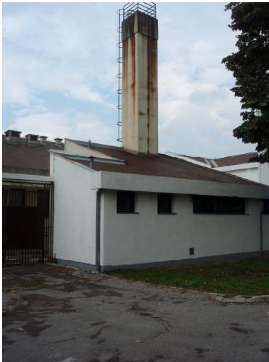
Fotografija 2: Prikaz lokacije kotlovnice.
